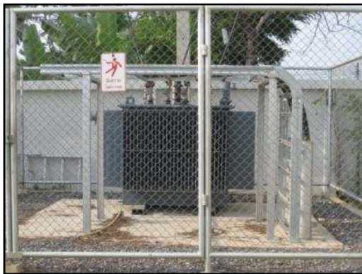
ภาพที่ 1-11 หม้อแปลงไฟฟ้าโครงการฯ
