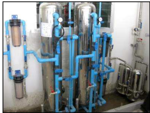
ภาพที่ 2-13 ระบบสารกรองน้ำชนิดต่างๆ ภายในพื้นที่
